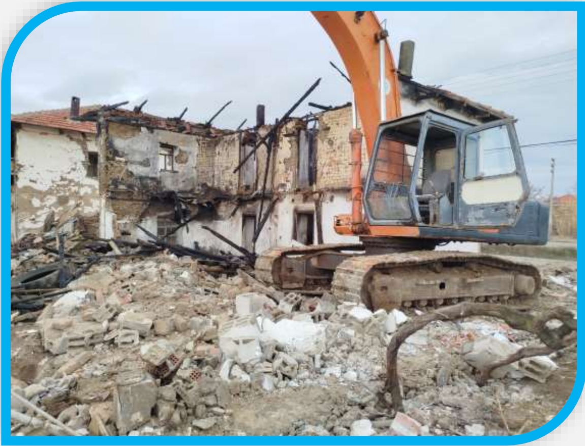
Yassihöyük mahallesi deprem hasarlı evlerin yıkımı
