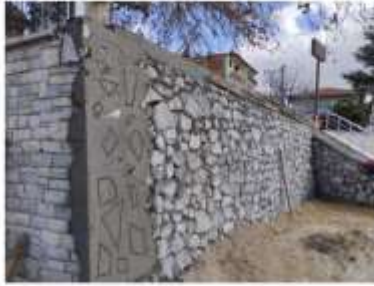
Yeşilyuva merkez istinat duvarı
