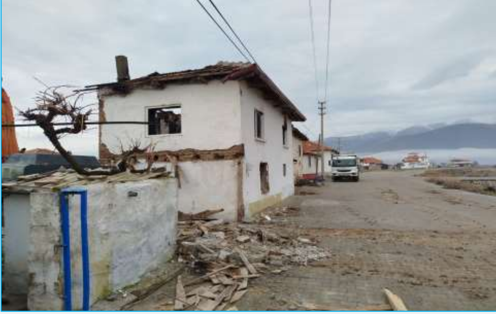
Yassihöyük mahallesi deprem hasarlı evlerin yıkımı
