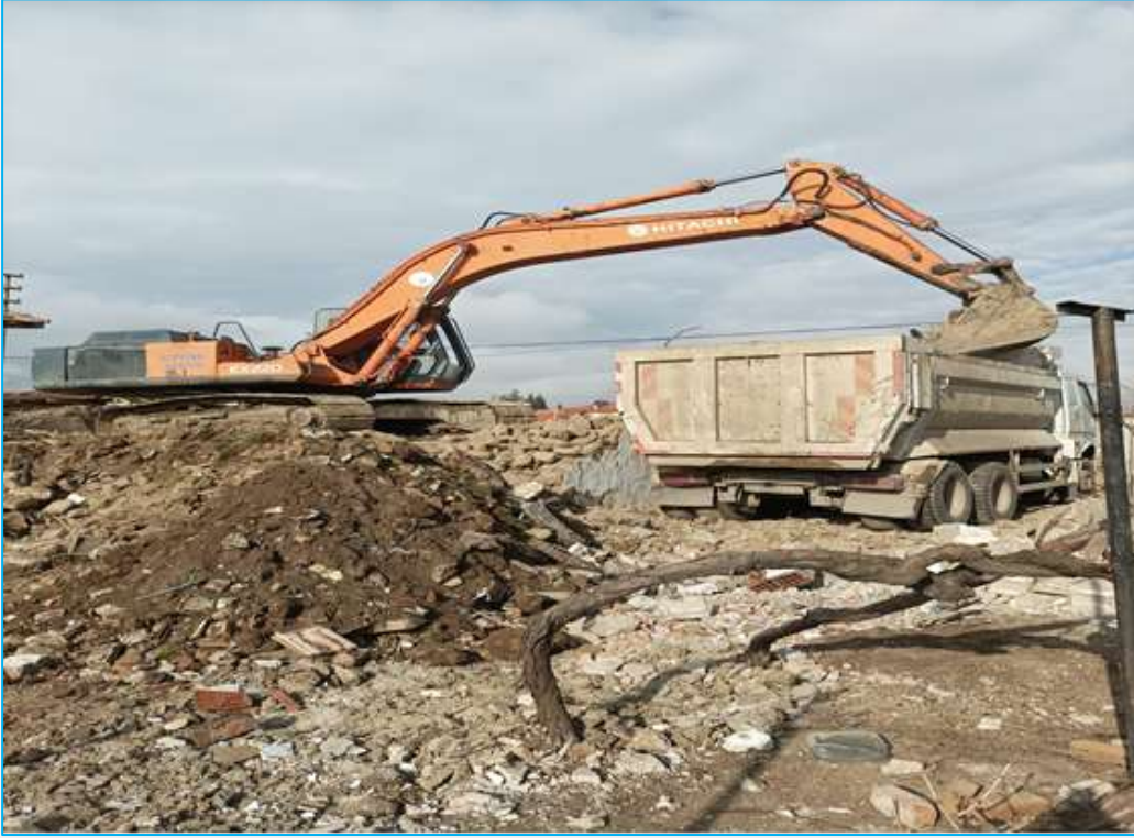
Yassihöyük mahallesi deprem hasarlı evlerin yıkımı
