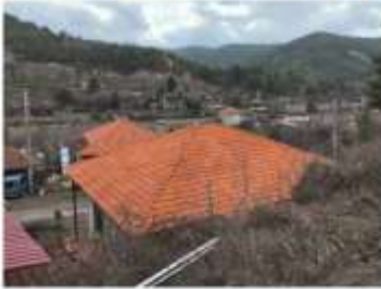
Boğazdere çatı yapıldı.
