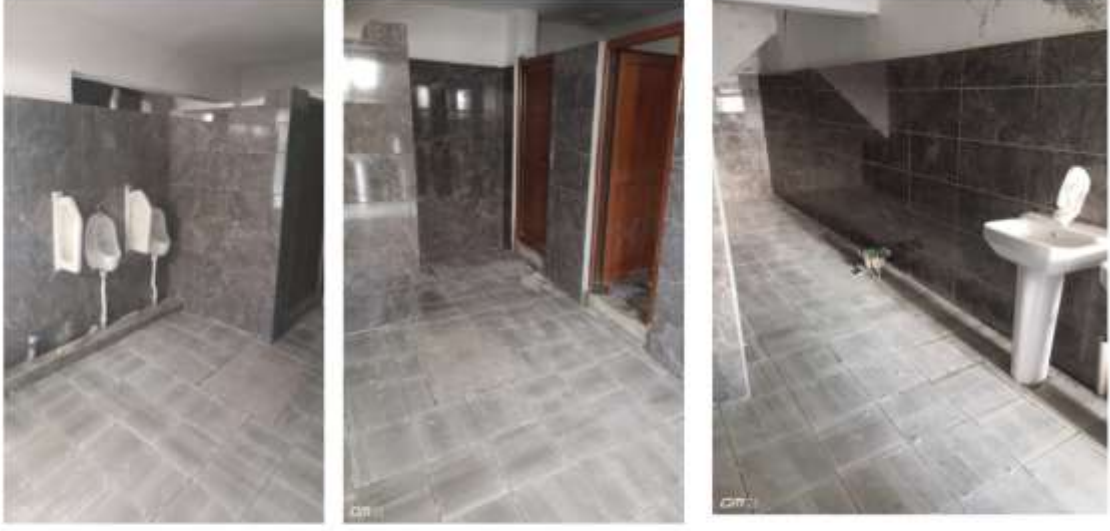
Yeşilyuva Mahallesi WC Yenileme
