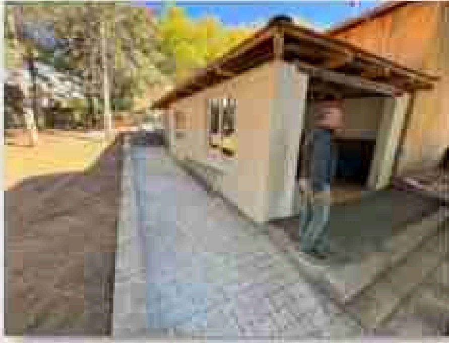
Çarını Mahallesi Sosyal Tesis Mutfak ve Tuvaleti
