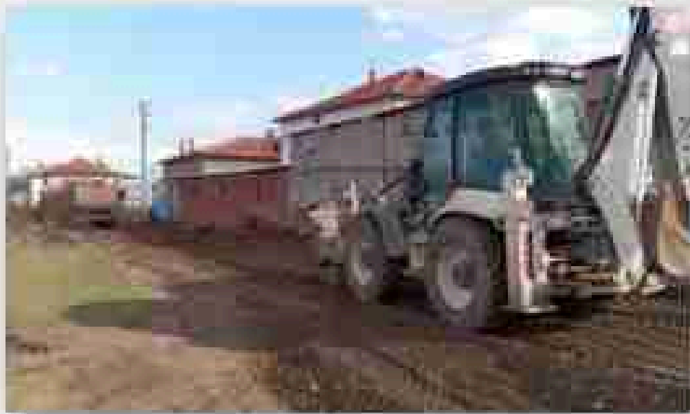
Aluntin Mahallesi ile Azırcayın Merkez Arası İmar Yolları Kamburcahan
