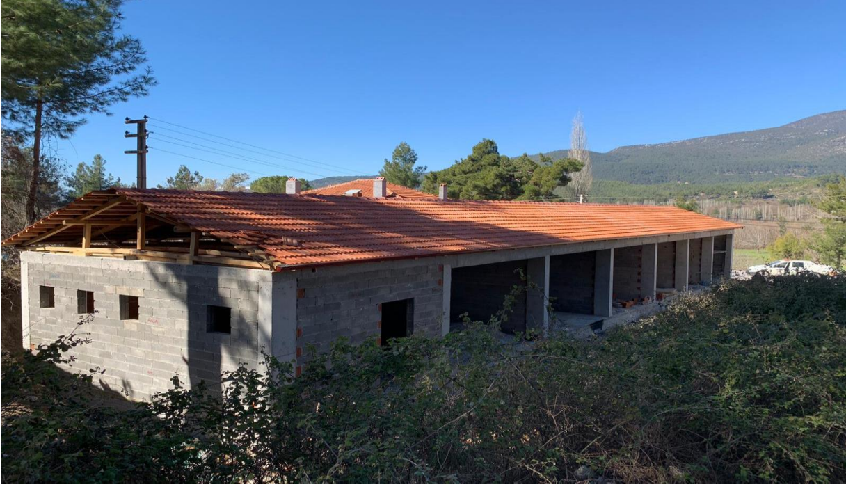
Gölcük Mahallesi 6 Adet İşyeri İnşaatı
