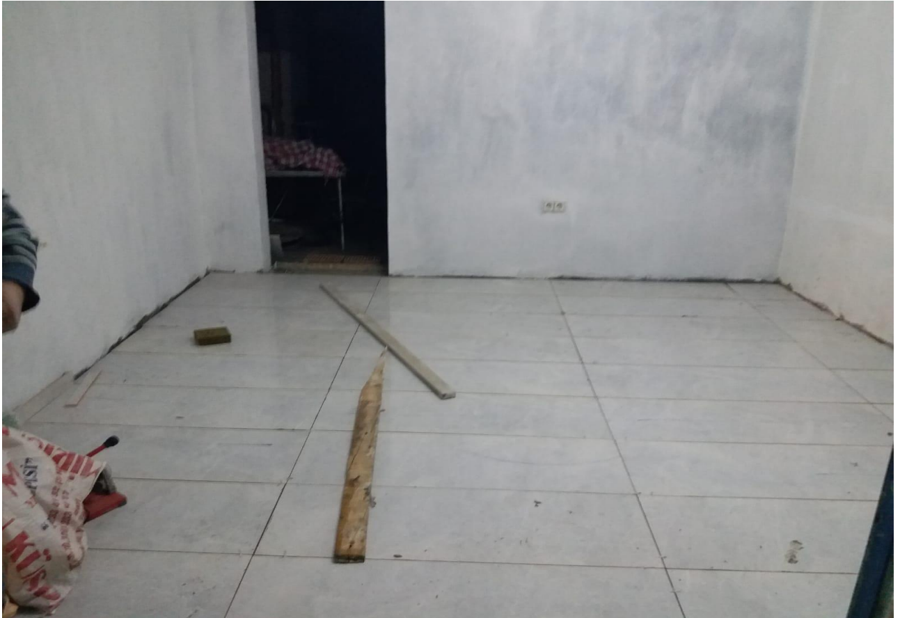
Kuzören Mahallesi Sağlık ocağı tadilatı
