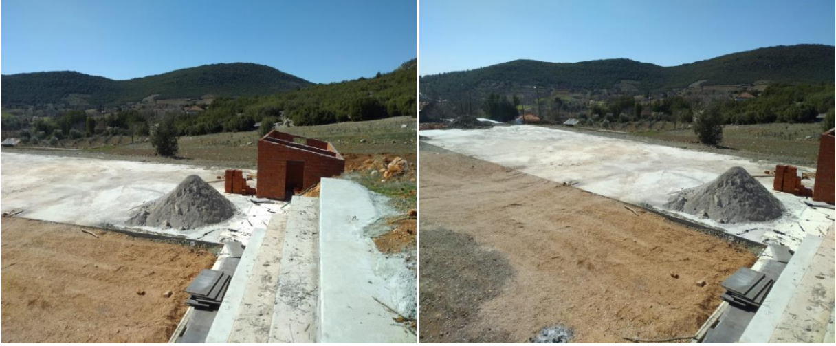
Hisar Mahallesi Kapalı Alan Temel ve Mutfak Çalışması
