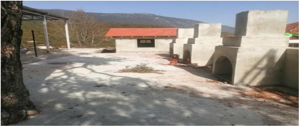
Olukbaşı Mahallesi Mutfak ve Ocaklık Çalışması
