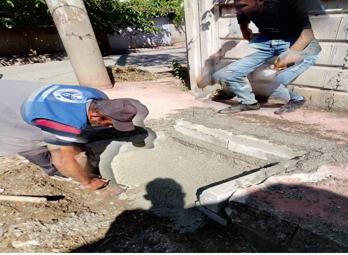
Temiz bir çevre için yol kenarlarına koyduğumuz konteynerlerimiz için alan yapım çalışmaları
