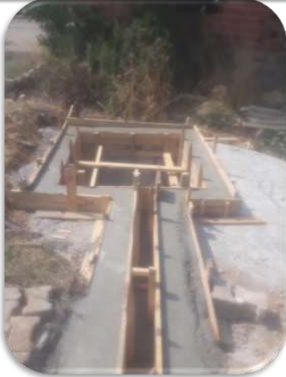
Yağmur suları için logar ve ızgara yapım
