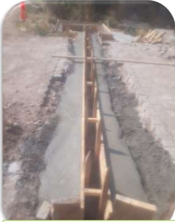
Yağmur suları için logar ve ızgara yapım
