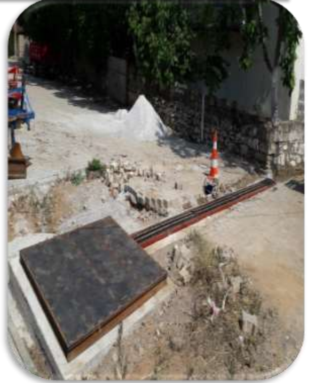
Yağmur suları için logar ve ızgara yapım
