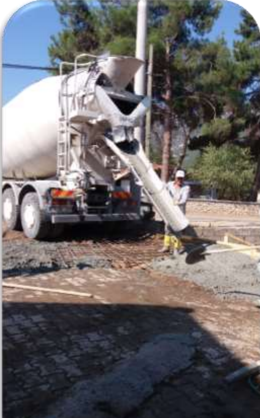
Kurtlar köprü yapımı(demir ve beton alımı)
